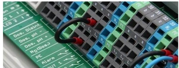
Puentes en el compartimento de terminales de la fase L<sub>F</sub> al contacto central 'a'
